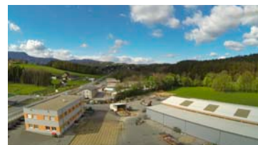
Rechts neben dem Firmengebäude wird das neue Zentrum für Regeneration gebaut.
